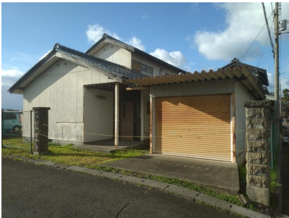
外観写真 長浜市八幡東町字西浦 542-24
