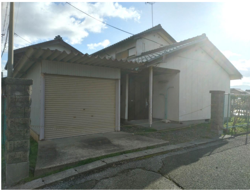
外観写真 長浜市八幡東町字西浦 542-22
